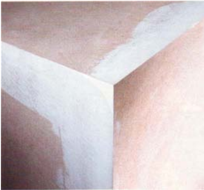
Die stark saugenden Schnittkanten werden mit Malerspachtel abgedeckt und glatt geschliffen.
