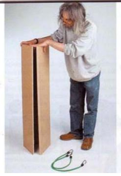
Auf dem mit Papier abgedeckten Fußboden gruppierten wir die drei Seitenteile so, dass sie sich gegenseitig um Umfallen hinderten. Die belehrte Kante lag jeweils innen. An deren oberen Teil lehnten wir die Innenfläche des anschließenden Brettes mit leichtem Winkel an. Die dritte Platte vervollständigte den Korpus. So bildeten die langen Schnittkanten der Breiter jeweils eine Innen- und eine Außenkante mit 30-Grad-Winkel.
